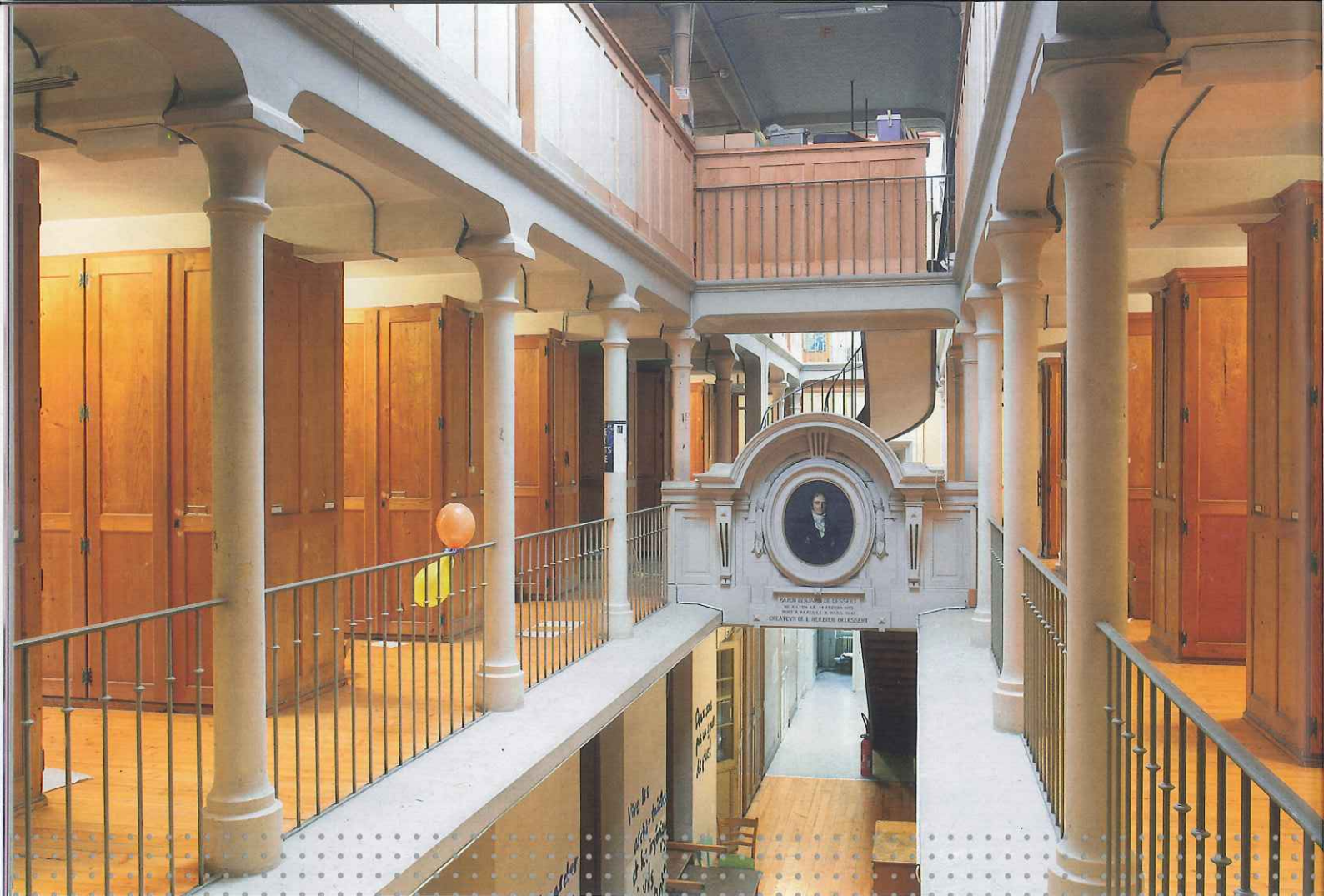
L'atrium, ce grand vide central sur 3 niveaux surmonté d'une verrière, est l'élément structurant le plus caractéristique de la Console.
